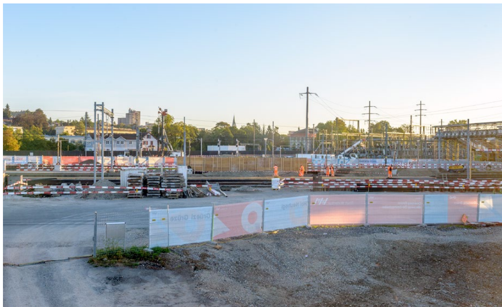
Baustelle Leonie-Moser-Brücke (Arnold Kohler)
