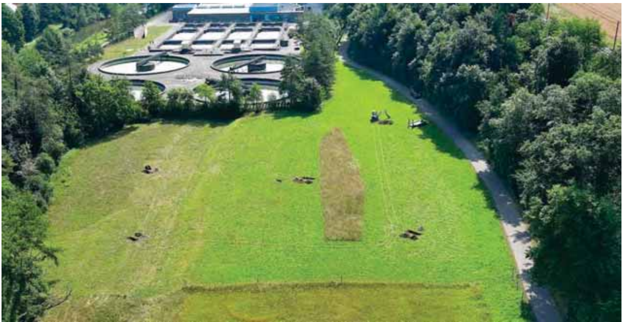
Foto 6: Untersuchungsperimeter mit offenen Profilgruben (Bildmitte) und bestehender ARA (obere Bildhälfte; Blick Richtung E; Luftaufnahme vom 6. Juli 2022).
