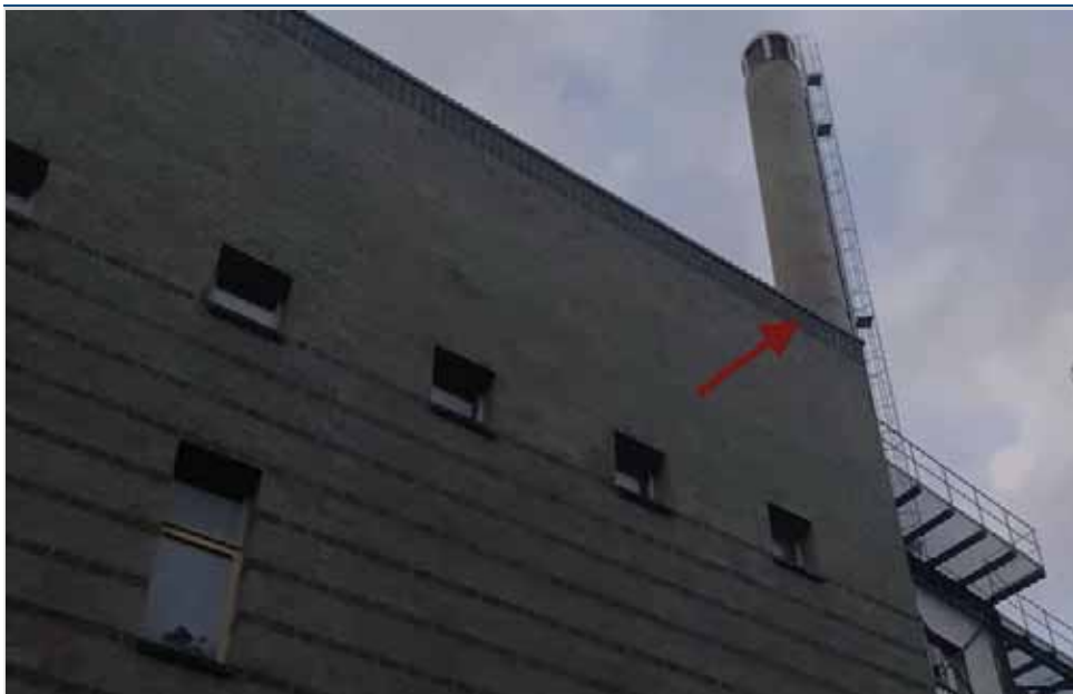
Abb. 4 Quartier am Gebäude der Schlammmentwässerung
