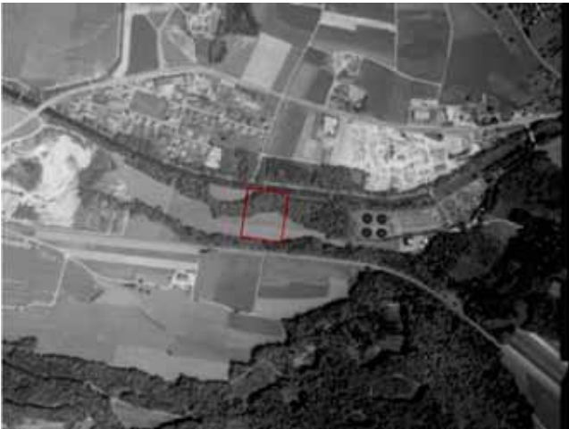
Abbildung 3: Orthofoto des Gebietes der ARA Hard vor Ausbau (1981).
