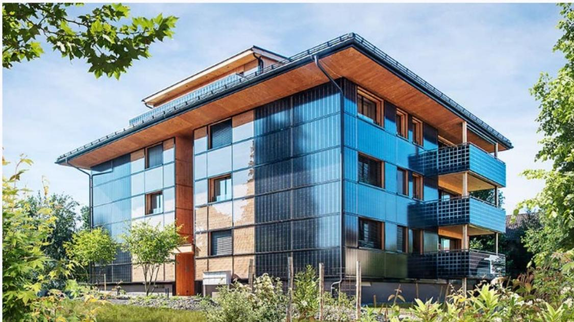
Abbildung 2: Dieses sanierte Mehrfamilienhaus in Fahrwangen produziert jährlich 78'000 kWh Solarstrom – dreimal mehr, als es selbst braucht – im Winterhalbjahr bleibt ein Überschuss von 7'700 kWh. (Foto: Schweizer Solarpreis 2022)
