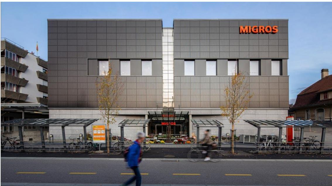
Abbildung 5 In der Migros-Filiale Münsingen hat die Genossenschaft Migros Aare im Jahr 2020 erstmals eine Solarfassade in Betrieb genommen. Die Fassade hat eine Fläche von 1'816 m<sup>2</sup>, wovon 1'233 m<sup>2</sup> mit Solarmodulen mit einer Gesamtleistung von 218.5 kWp belegt sind. ([Link](#), © Migros)
