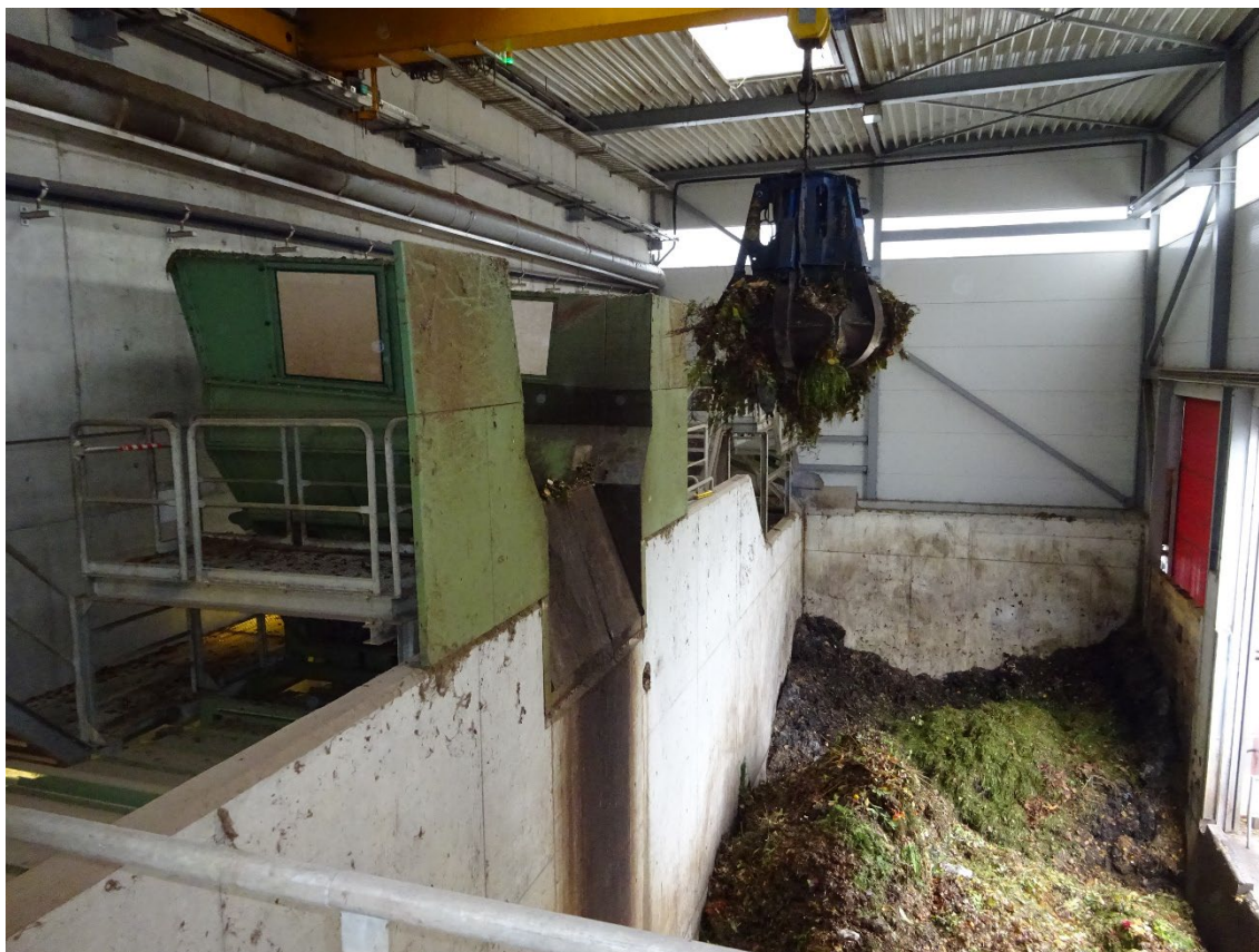
Abbildung 4: Tiefenbunker mit Krananlage (Foto: Ecosens)
