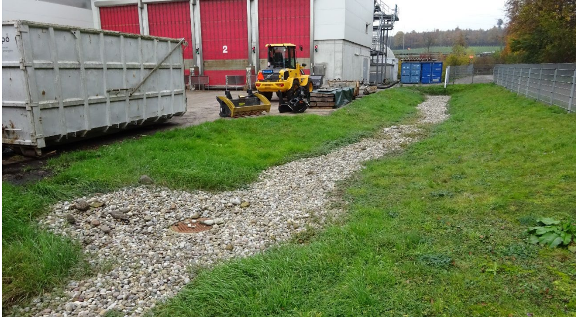
Abbildung 16: Versickerungsanlage im östlichen Arealteil (Quelle: Ecosens)
