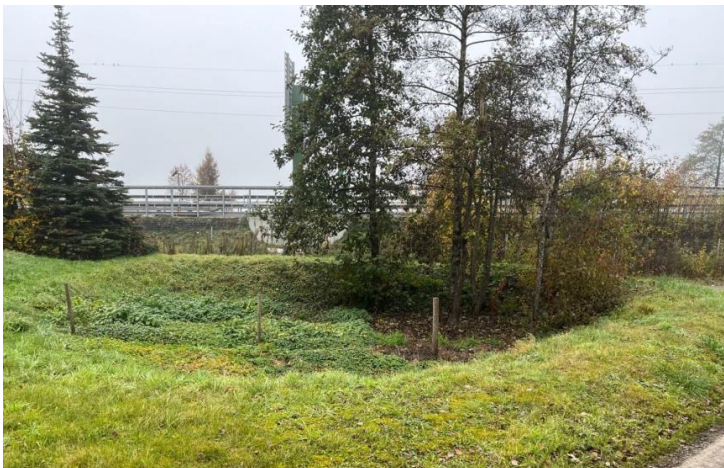
Abb. 3.4 Bestehendes Retentionsbecken mit Bepflanzung.
