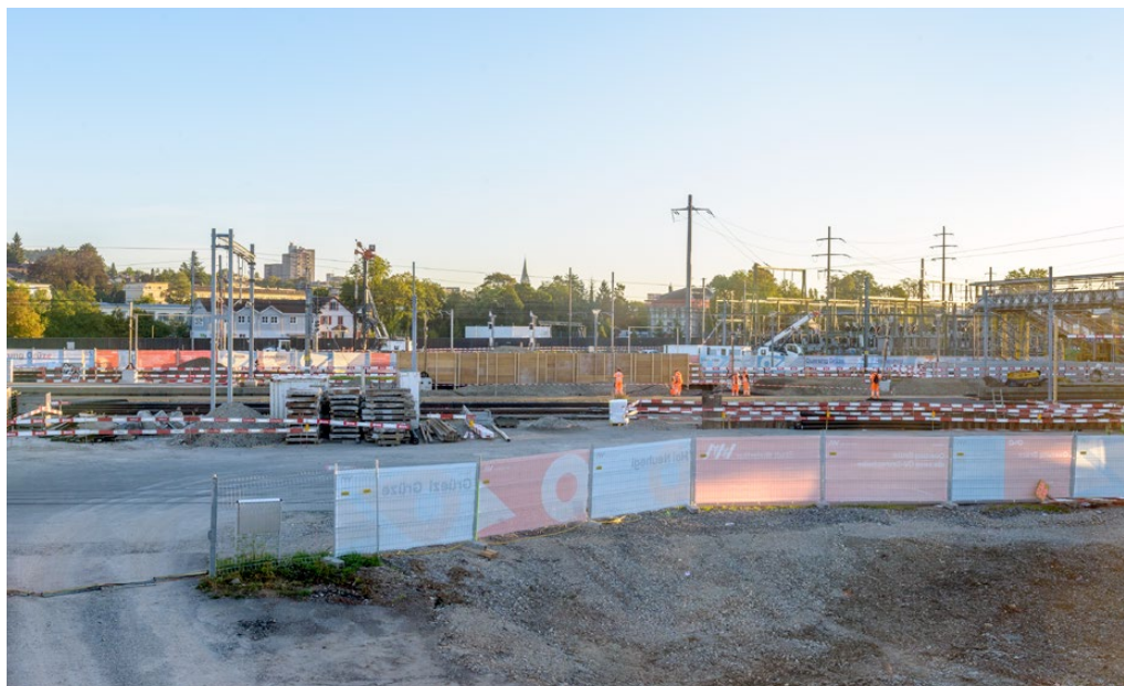
Baustelle Leonie-Moser-Brücke (Arnold Kohler)
