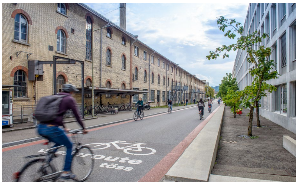
Winterthurer Veloroute Tössfeldstrasse (Arnold Kohler)
