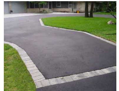
Randabschluss Wege mit Betonplatten/-Steinen
