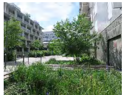
Gebäudeerschliessung über Brücken
