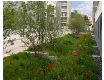
Von Entwässerungsmulden umgebene Gebäude
