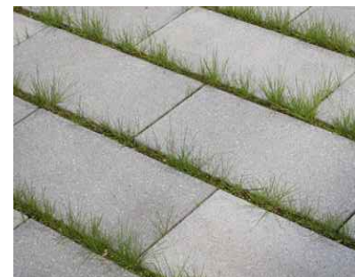
Beispiel Plattenbelag mit offenen Fugen
