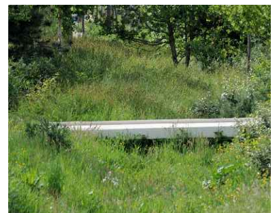
Brücke über begrünte Mulde
