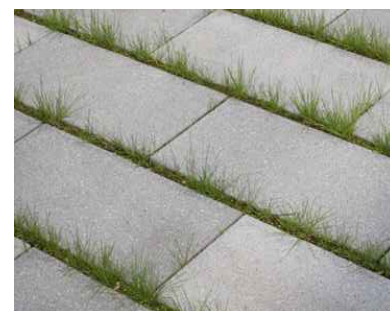
Beispiel Plattenbelag mit offenen Fugen
