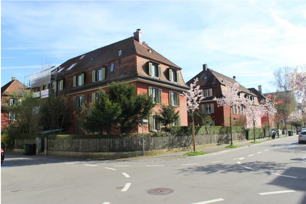
Abb. Salstrasse 39 und 41, Ansicht von Südosten
