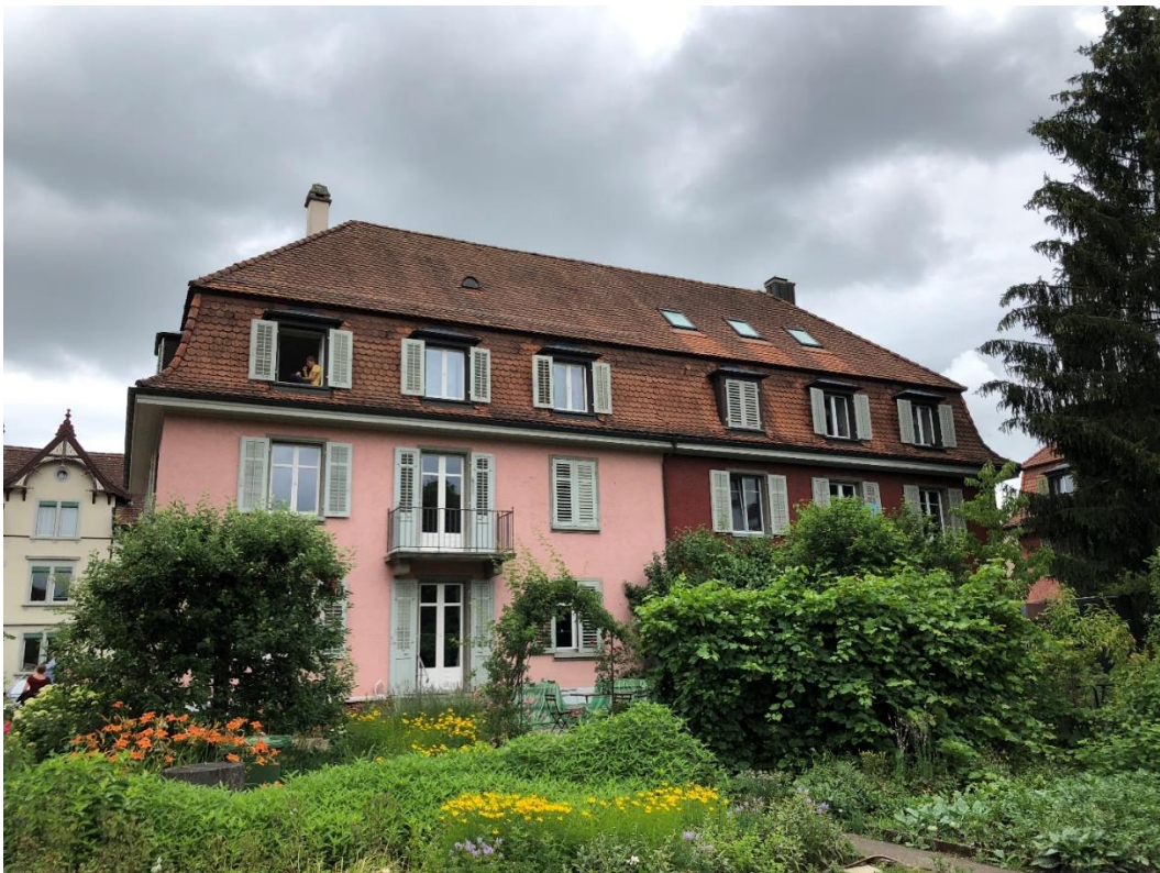
Abb. Ansicht Innenhof gegen Walkstrasse 12 und 14, Ansicht von Nordwesten
