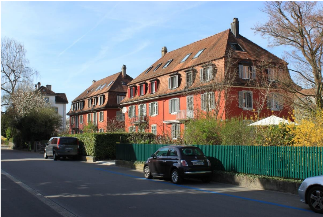
Abb. Ackeretstrasse 12, 14 und 16, Walkestrasse 10, Ansicht von Nordwesten
