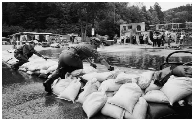
Das Stützpunkt-Rettungsdetachement demonstriert am Behördentag wie eine Wassersperre erstellt wird.
