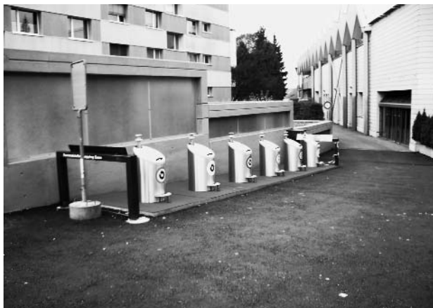
Die Unterflursammelstelle beim Einkaufszentrum Seen verhindert Lärmemissionen und schafft Ordnung.
