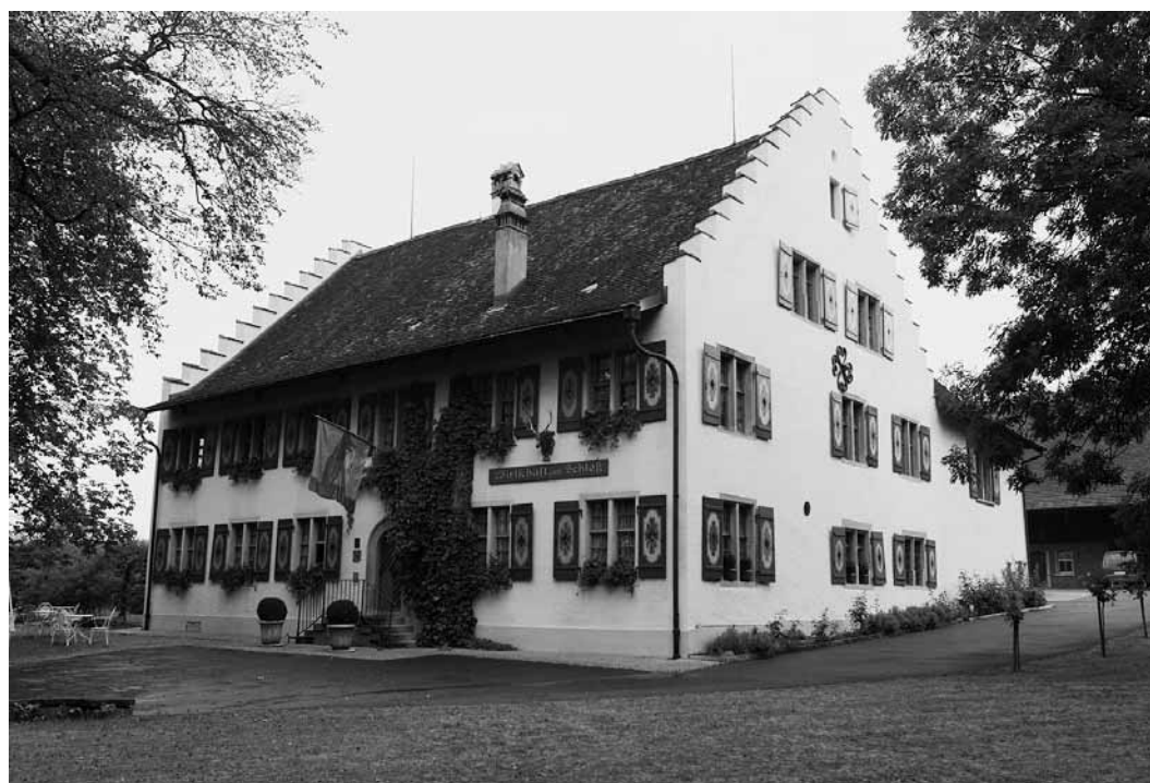
Die Sanierung des Schlosses Wülflingen soll im August 2008 abgeschlossen sein.
