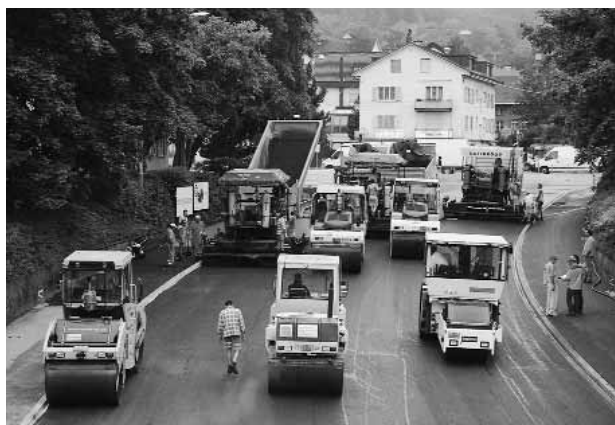
Belageinbau am Knoten Frauenfelderstrasse/Seenerstrasse
