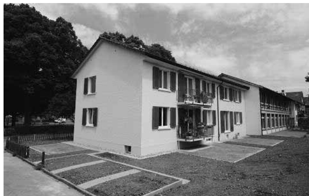
Die sanierte Liegenschaft Strittackerstrasse 31.
