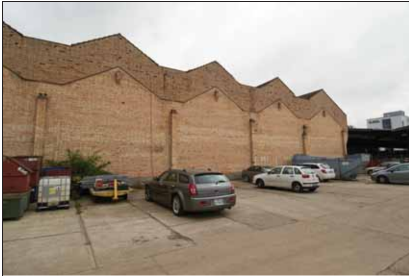
Blick gegen Osten und die Lagerhalle 555 (vermietet bis 31.12.2015). Hier soll der ebenflächige Rollbereich erstellt werden.
