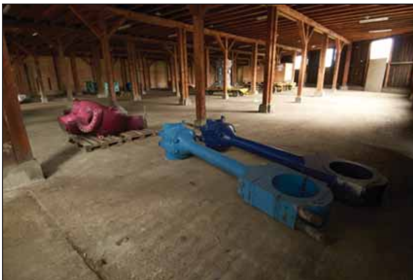
Die Holzkonstruktion der Halle 555 muss bis auf die Grundmauern abgebrochen werden. Hier entsteht der wellenförmige Rollbereich. Die Gussteile werden als Zeugen der Industriegeschichte in die Anlage integriert.
