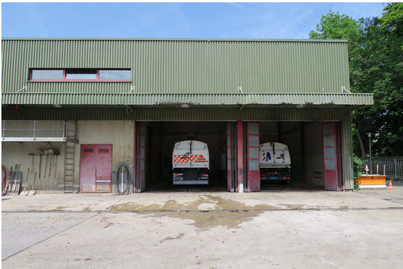
Werkstattgebäude, Ansicht von Südosten; Waschräume
