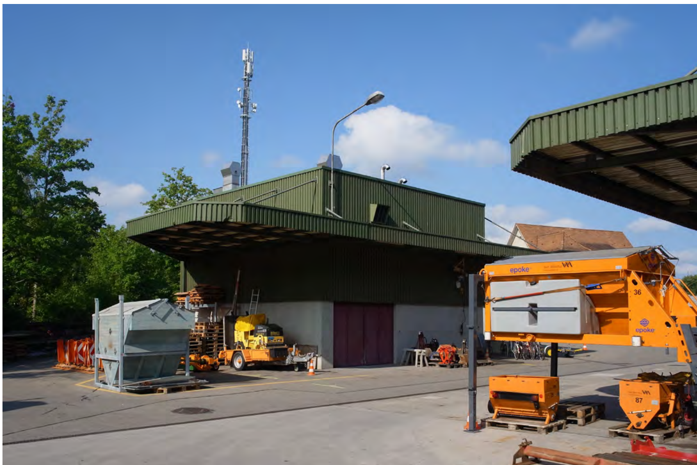
Nebenbetriebe, Ansicht von Osten
