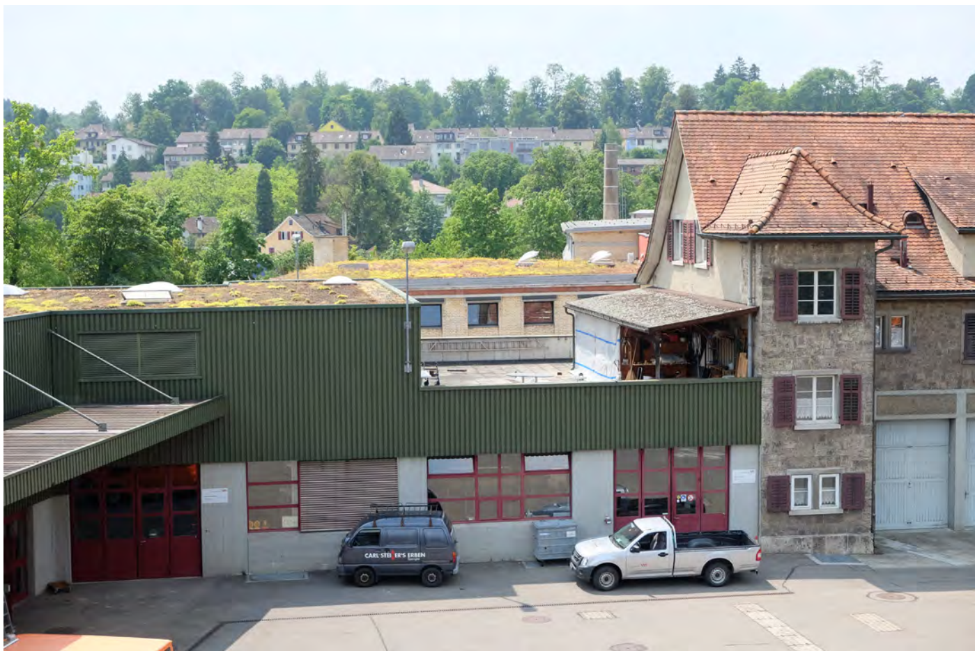
Nebenbetriebe und altes Wohnhaus, Ansicht von Norden
