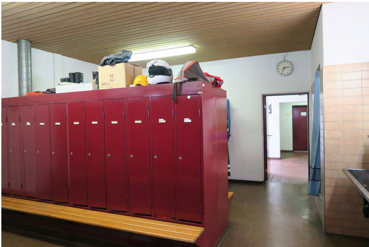
Werkstattgebäude, Obergeschoss; bestehende Garderobe
