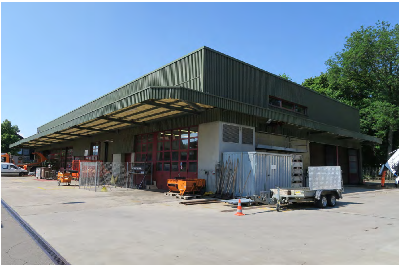
Werkstattgebäude, Ansicht von Süden
