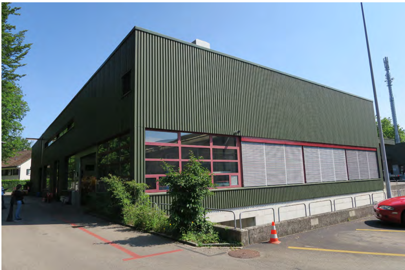
Werkstattgebäude, Ansicht von Nordwesten
