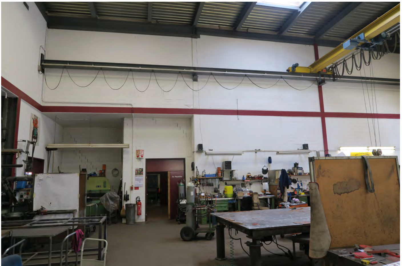
Werkstattgebäude, Erdgeschoss; Schlosserei
