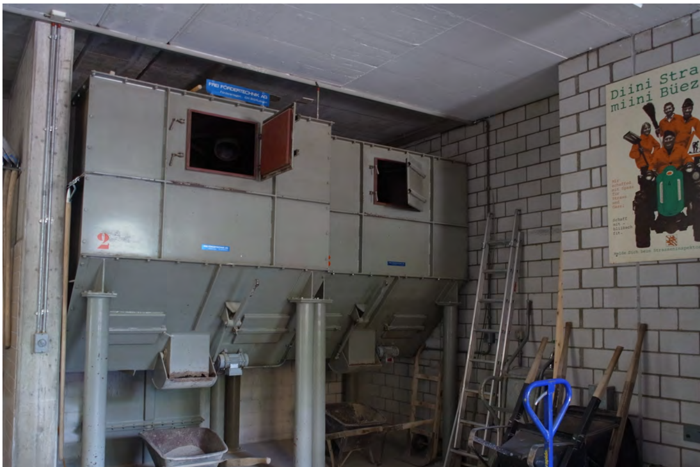
Nebenbetriebe; bestehende Zementerei
