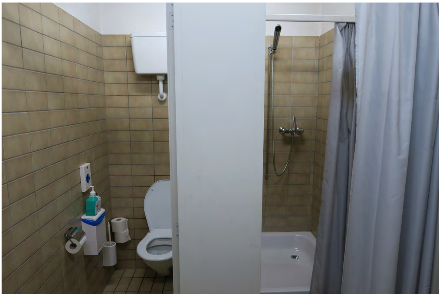
Werkstattgebäude, Obergeschoss; bestehende Dusche und WC in Garderobe
