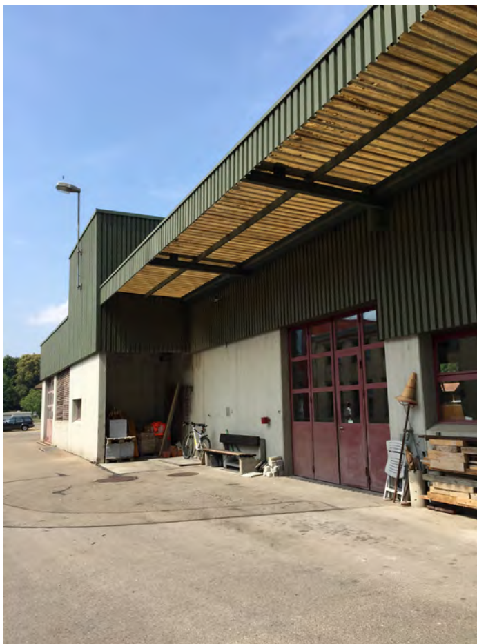
Nebenbetriebe, Ansicht von Westen
