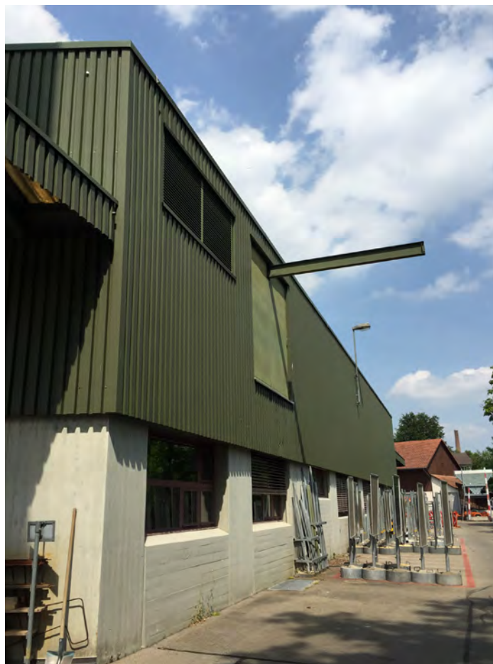
Nebenbetriebe, Ansicht von Süden
