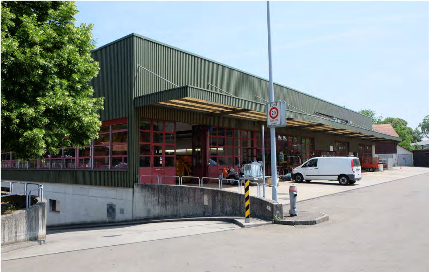
Werkstattgebäude, Ansicht von Westen; Tiefgaragenrampe im Vordergrund
