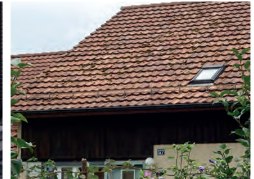
Fassade mit Holzverkleidung
