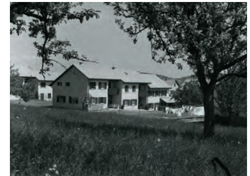
Grabenackerstr. 95 bis 103 Süden
