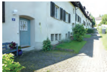
Reste der Natursteinbelägen erhalten, neues «fließendes» Belagsmaterial
